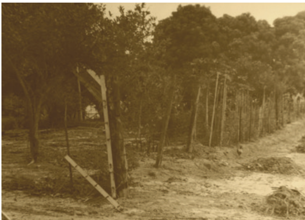
Figura 2: As ruas modificam o entorno da Chácara Araújo em 1969. Fonte: Museu da Cidade Salto.
