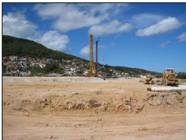
FIGURA 9: Obras de aterramento e fechamento do canal da Costeira, para ligar a Via Expressa Sul às vias de acesso ao Sul da Ilha. Houve a supressão da cobertura vegetal, impactando todas as faixas (transição, arbóreas e Spartina – em março de 2004).
