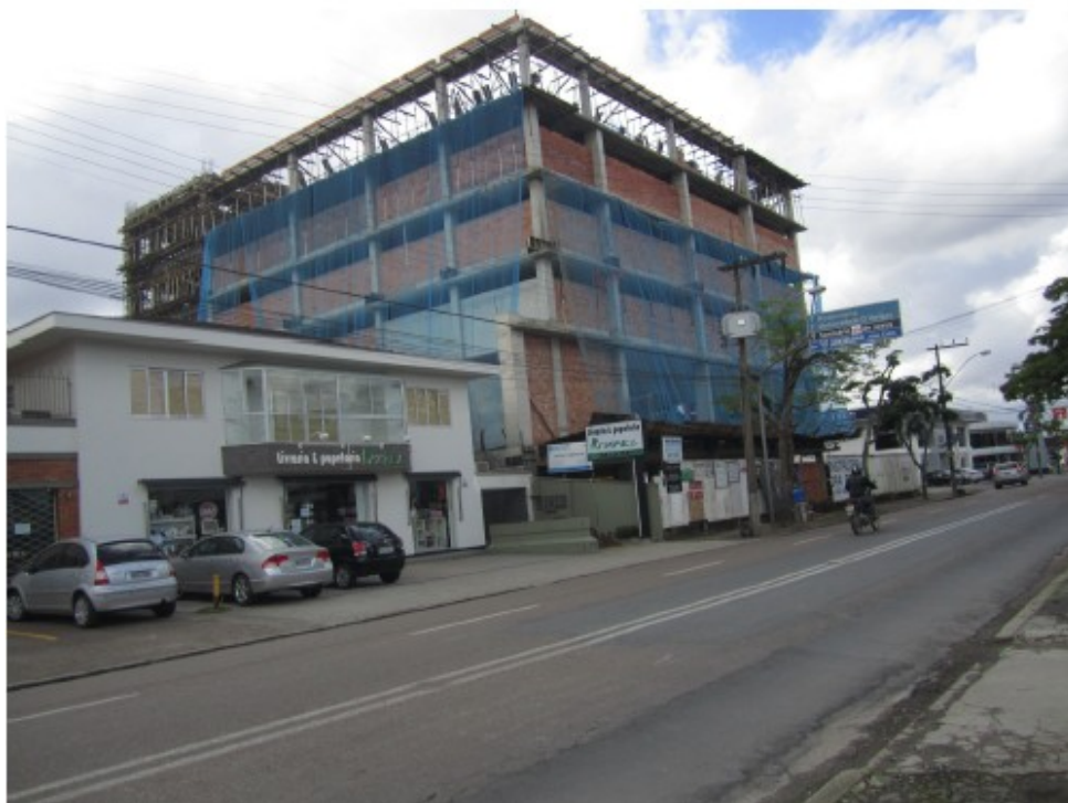
Imagem 03: O prédio em construção.
