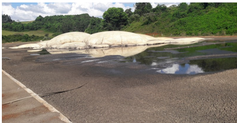
Figura 3 - Biodigestor da São Roque II desativação/fatores climáticos e Sedimentação de lodo
