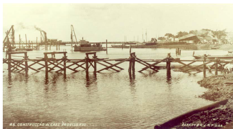
Fig. 2: Construção do Caés provisório. 1922. Fonte: acervo CHJP.
