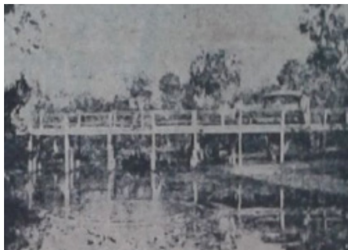
Figura 2 - Estrada carroçável que dava acesso à praia de Coqueiro
