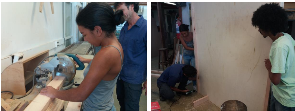
Ilustração 11 e 12 – Oficina Prática no LabMoMa: construção das divisórias.
