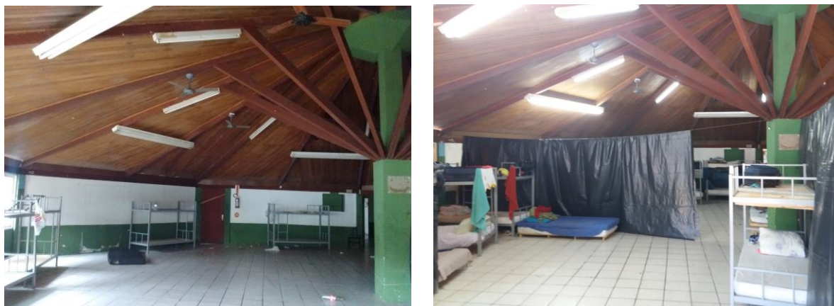
Ilustração 2 e 3 – Vista interna do alojamento e divisórias em lona.
