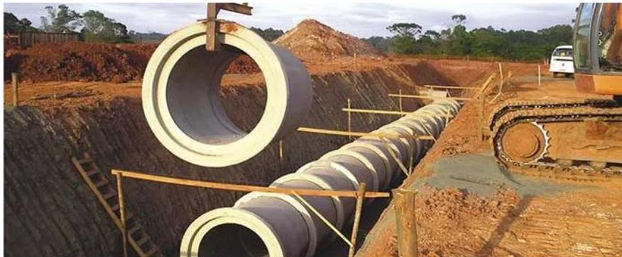
Exemplo de galerias pluviais cilíndricas.
