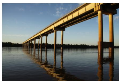
A Ponte foi construída por um consórcio privado e inaugurada em 1997, com um contrato de concessão válido por 25 anos. Foto: Divulgação/Prefeitura de São Borja
