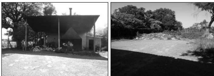
FIGURA 03: Instalações da Estação de Tratamento dos resíduos
