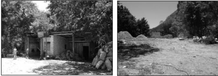
FIGURA 07: Instalações da Estação de Triagem e Aterro
