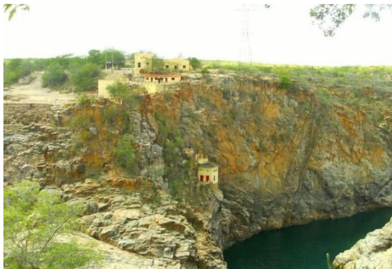
Figura 4: Usina Hidrelétrica de Angiquinho no município de Delmiro Gouveia-AL. Foto do autor, 2012.
