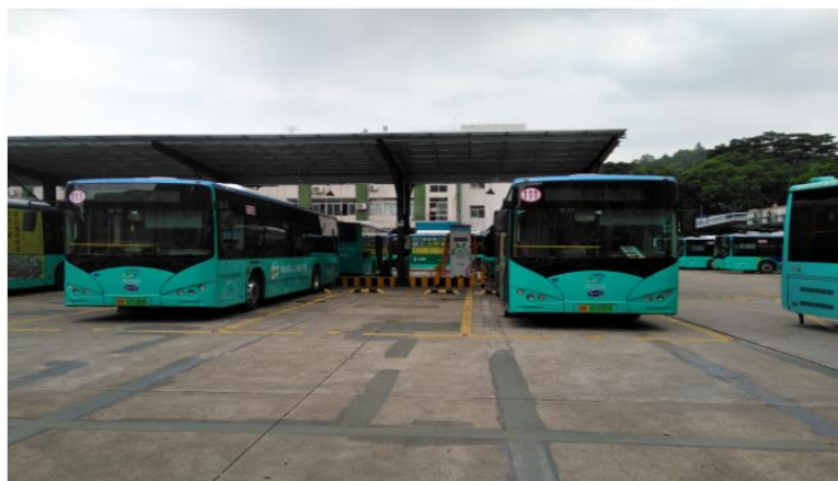
Figura 4 - Estação de carregamento elétrico para ônibus em Shenzhen
