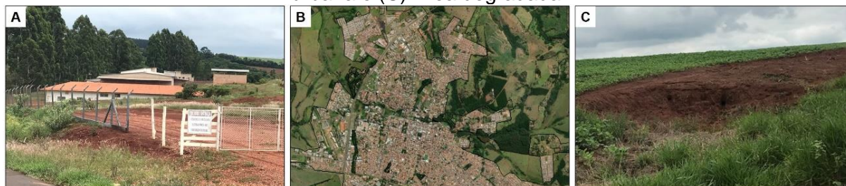
Figura 6- Imagens de campo representativas das classes (A) Infraestrutura (B) Malha urbana e (C) Área degradada.
