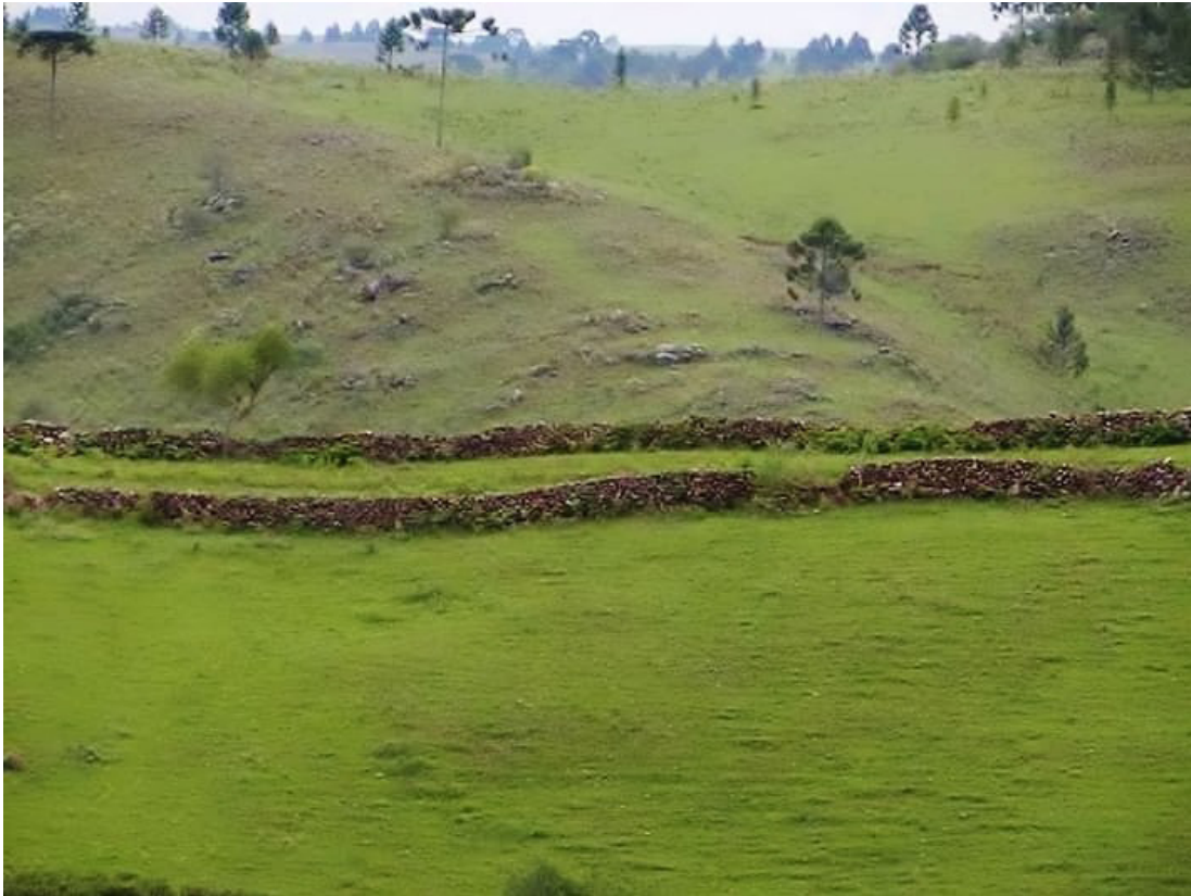
Figura 3 – Detalhe do corredor de taipas para deslocamento de tropas
