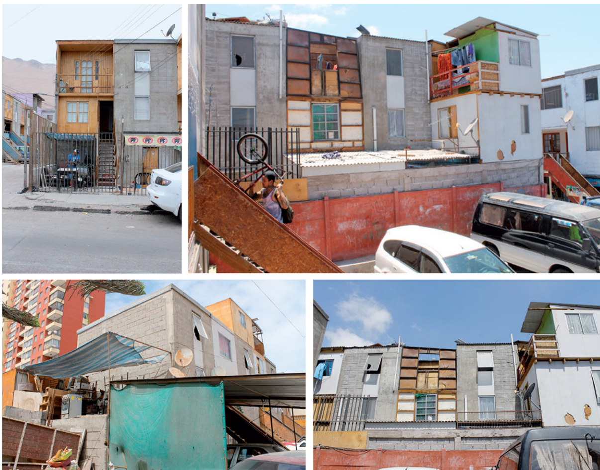
Figuras 16 a 19: Ampliações do projeto original de Quinta Monroy após reassentamento dos moradores
