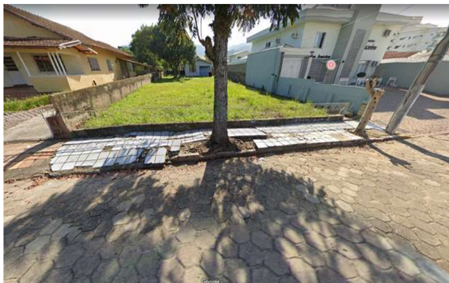
Figura 2 - Calçada danificada na Rua Prefeito Raulino Rosar
