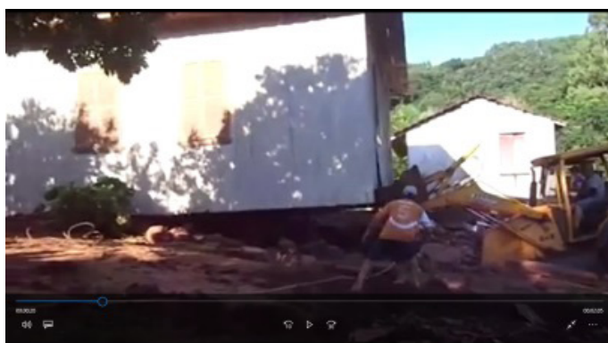
Figura 2. cena em 00:20 – Casa em movimento e o início dos danos
